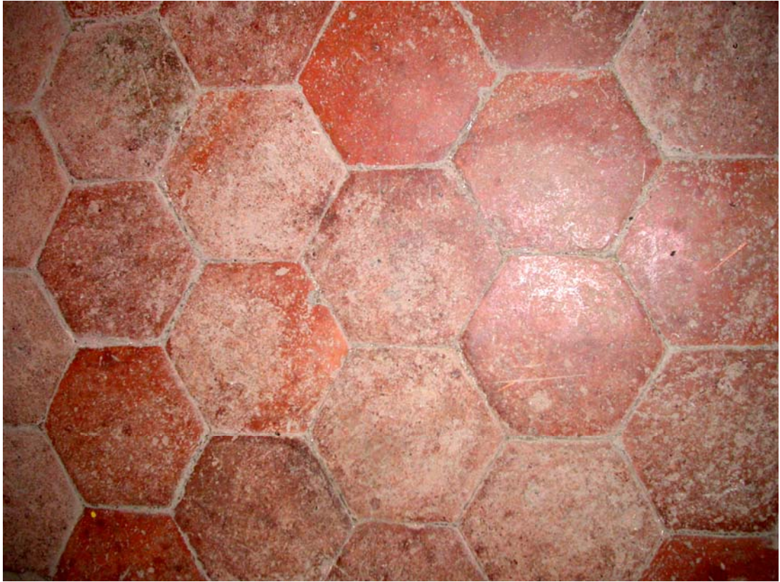
Le sol à l'ancienne du galetas. On y mettait la lessive à sécher.
